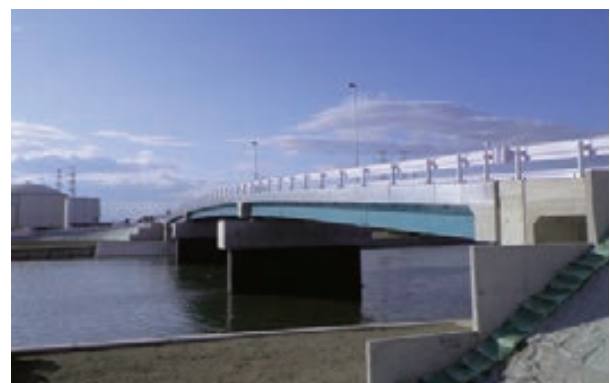
新設した「東西地区連絡橋」
