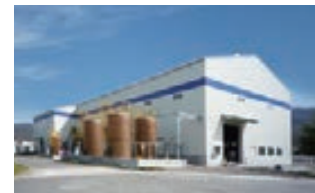
JX日鉱日石金属敦賀工場 (電池リサイクル工場)
