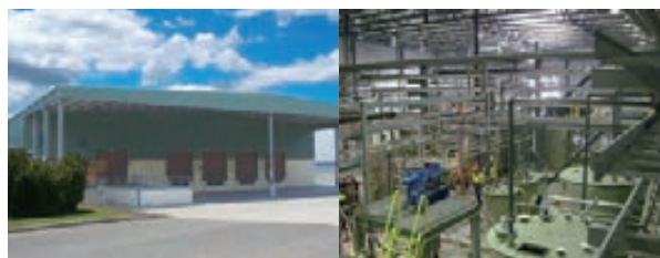
パイロットプラント施設外観
